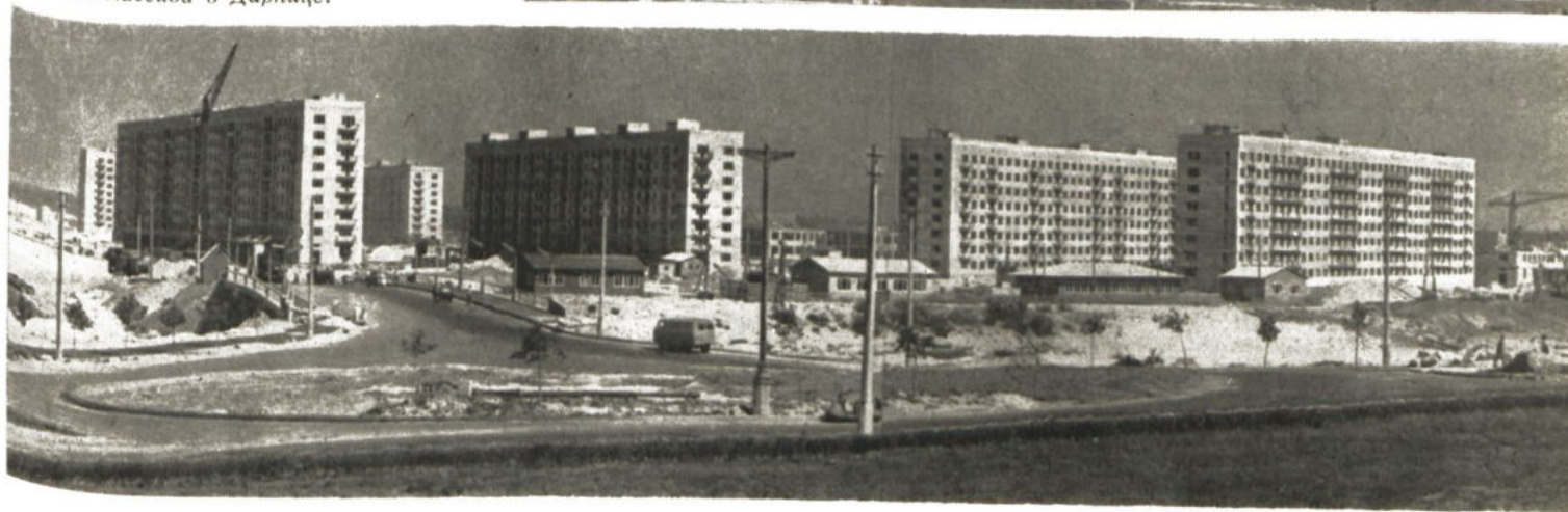
Строительство Русановского жилого массива в Дарнице.
